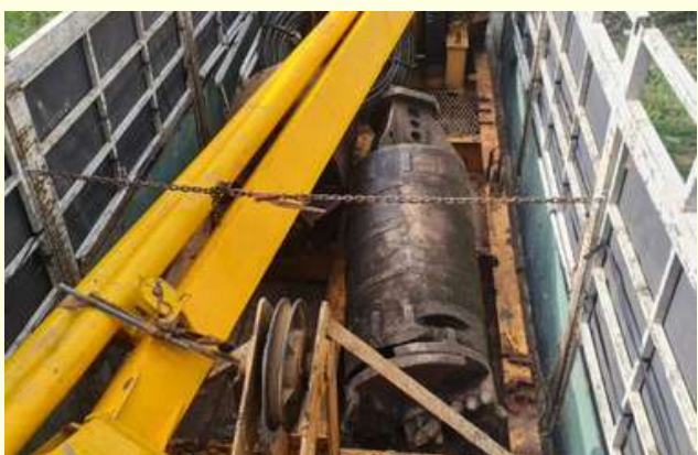
GIÀN ĐẬP ĐÁ, CỌC KHOAN NHỒI
