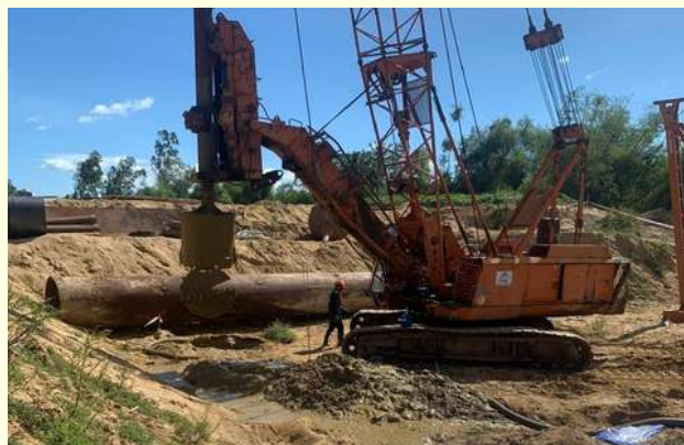
MÁY KHOAN CỌC NHỎ
